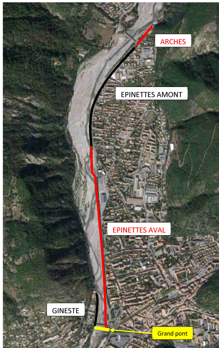
Figure 1 : Les digues en amont du grand pont
