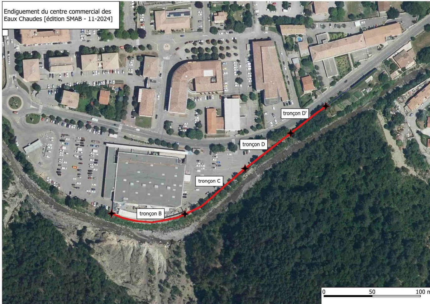
Figure 1 : La digue du centre commercial
