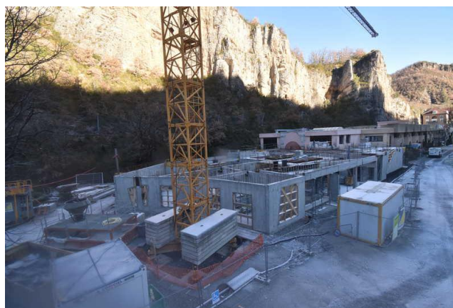
Vue de l'état d'avancement du chantier au 31 décembre 2019
